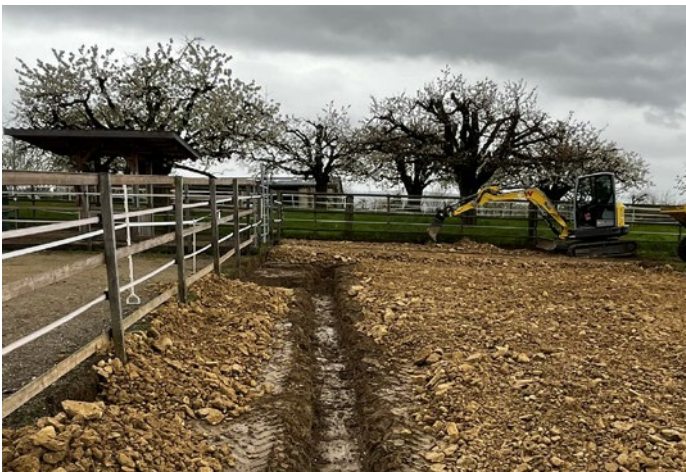
Graben für Wasser- und Stromleitungen
