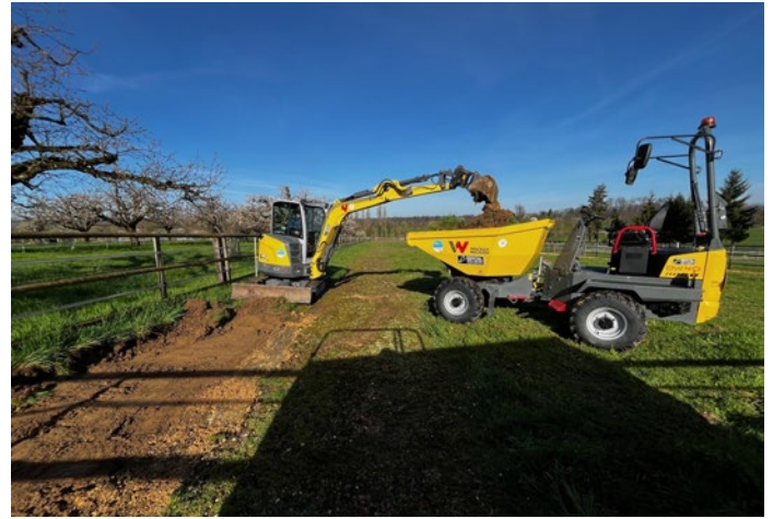
Vorbereitung für die Grabarbeiten
